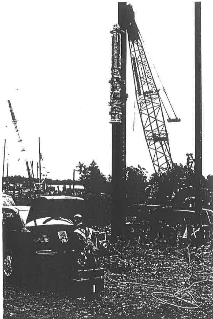
5. - Control de la hinca con el PDA
