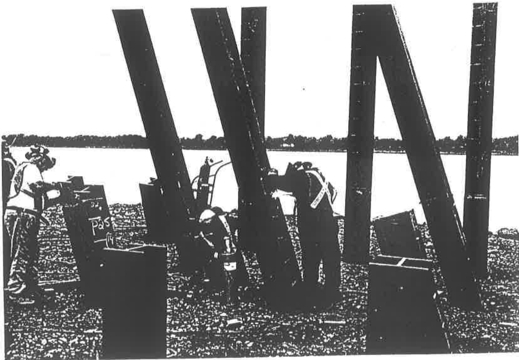
4. - Aspecto de conjunto de pilotes en pilas en tierra, durante la operación de soldadura
